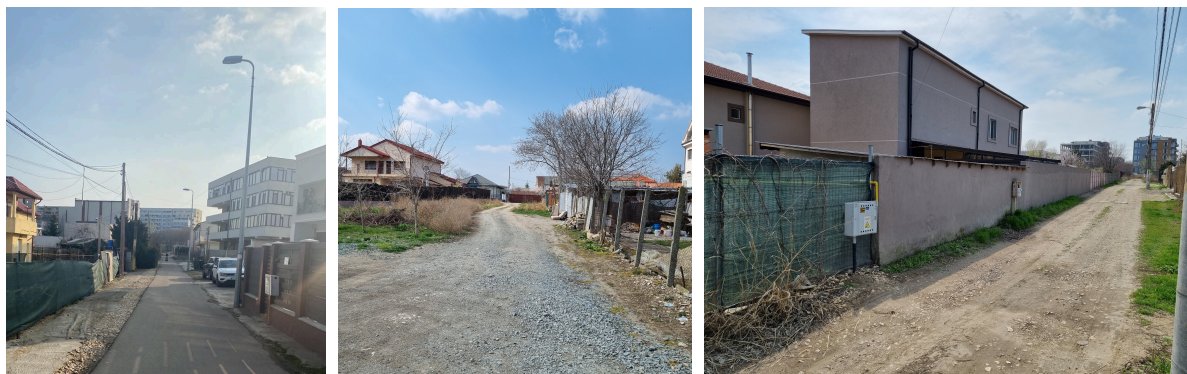
Exemple de străzi subdimensionate, fără amenajare corespunzătoare - Strada E. Lovinescu, Str. Salviei, str. Zăvoiuului
